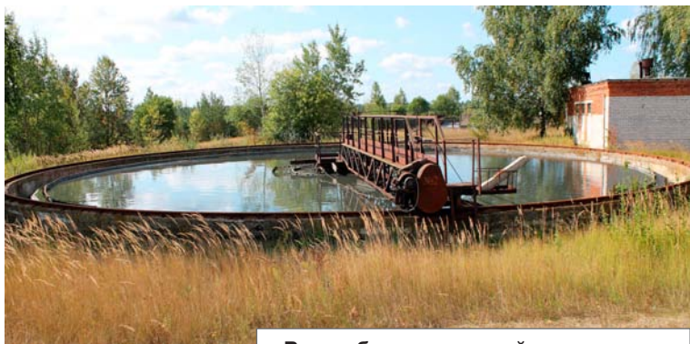
В этом большом отстойнике из стоков удаляются песок и мусор
