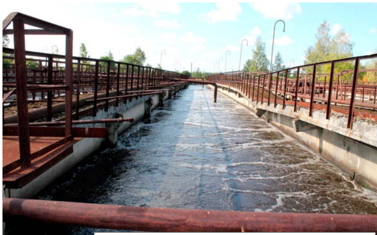
В этих аэротенках происходит биологический процесс очистки стоков
